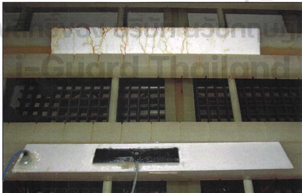
รูปที่ 4: การทดสอบภายในตู้หลังทดสอบ
